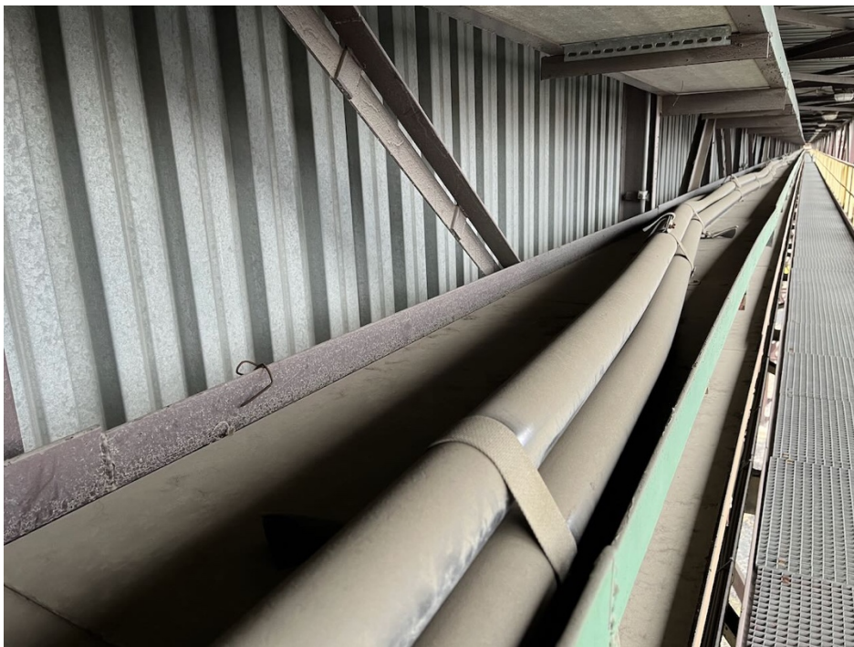
3- kabel bez vhodných kabelových příchytok, nebo závěsů
