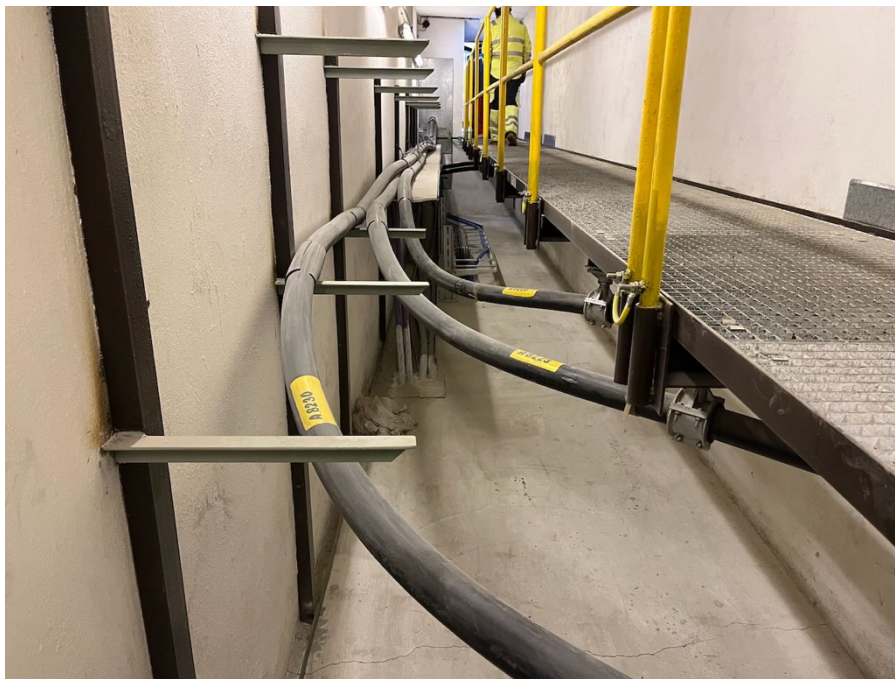
1- kabelové vedení T112 volně položené na kovové výložníky, bez použití přichytek
