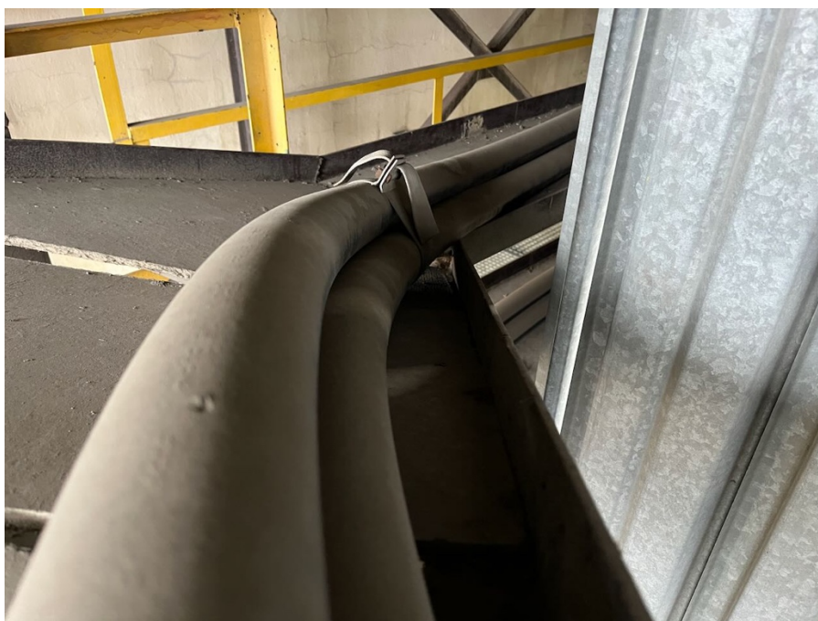
3- kabel je vlivem dilatace mostu natlačen na ostrou hranu kabelové lávky
